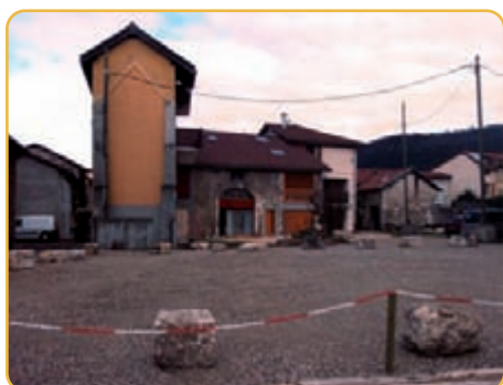
Place Centre-Bourg (Démolition pour futur place publique)
