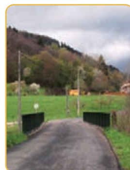
Route du Paris (Garde du corps du pont de la Morge)
