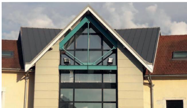
Remplacement des feuilles en zinc par des éléments neufs en zinc quartz. Les travaux se sont élevés à 30 946 €.
