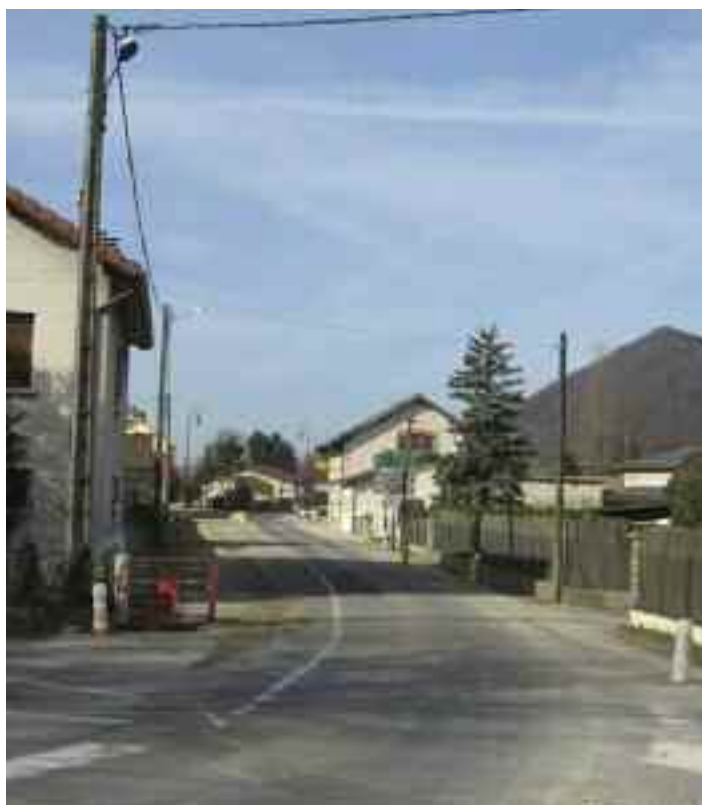
Enfouissement des réseaux et réaménagement total de la rue du Tram
