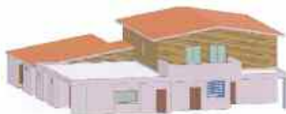
Construction du local Foot Camping Gardien (FCG)
