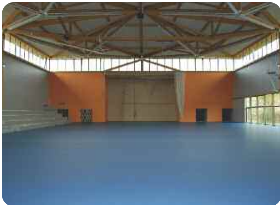
La grande salle, ses gradins et son mur d'escalade
