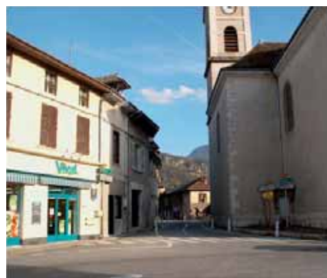
Aménagement du centre - bourg 867387€ (projet sur plusieurs années) - Travaux de voirie 824 519 € (dont l'aménagement de la rue du Magnin)
