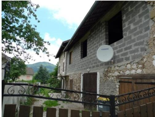
Certaines réhabilitations peuvent mettre à mal le patrimoine vernaculaire traditionnel : crépin et enduit de façade en ciment mal adapté au pisé ou à la perméabilité des matériaux traditionnel, repris de mur en parpaings sur du galet traditionnel...
