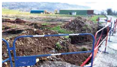
09/01 : reconnaissance et installation chantier
