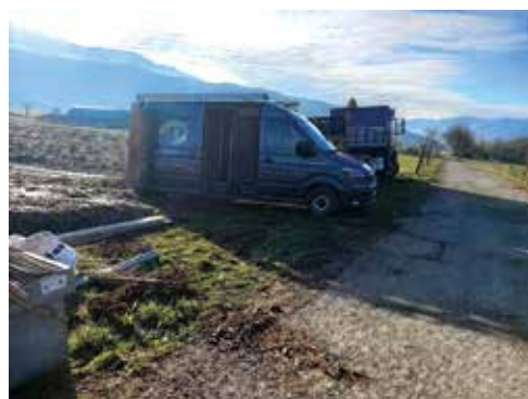
23/03 : chantier balisé à l'arrêt
