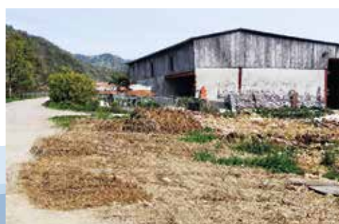
10/04 : comblement tranchée Enedis
